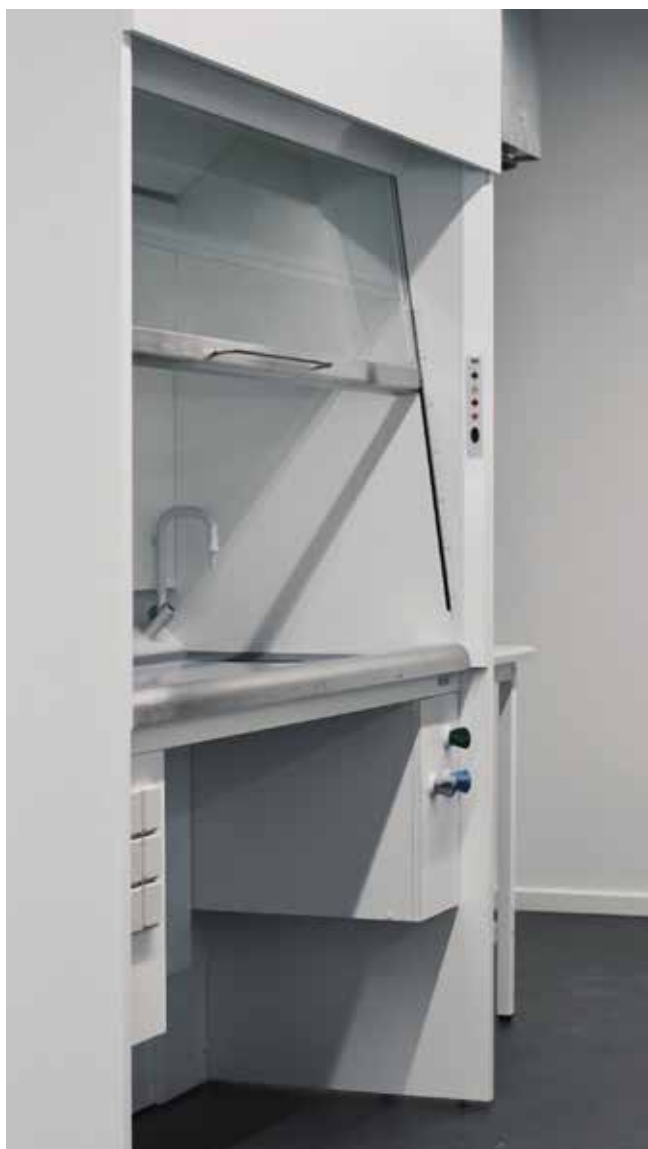
Figur 15. Eksempel på stinkskalet med betjeningsgreb og kontakter i fronten.
