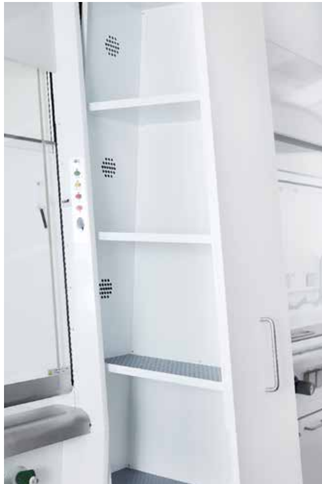
Figur 11. Eksempel på kemikalieskab i form af udtrækskab på siden af stinkskab.
